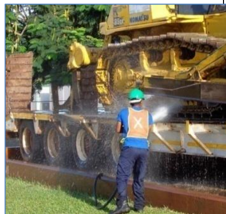
Limpeza do equipamento de terraplenagem trazido para a área de construção da linha ramal para a prevenção de plantas invasivas.
